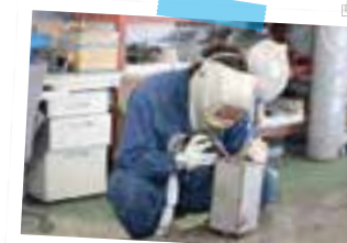
水漏れ等の原因にもなるので溶接には細心の注意を払います!
